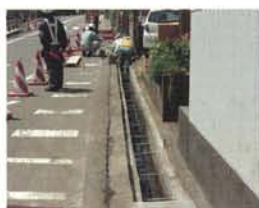
3 漏れ止め金具設置状況
