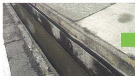
漏れ止めパッキン貼り付け
