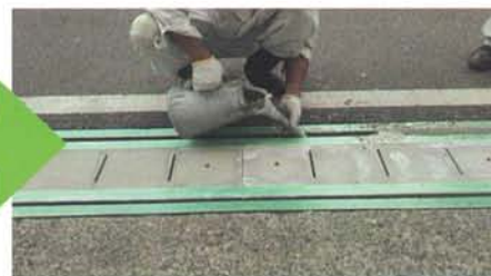
充填剤注入し硬化後完了
