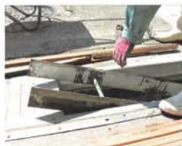
8 漏れ止め金具撤去
