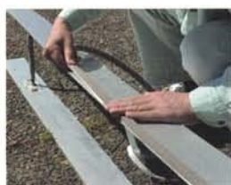
2 漏れ止めパッキンの貼り付け
