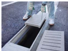
軽量二次蓋の設置
