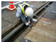
漏れ止め部材設置
