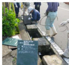
②既設側溝蓋撤去
