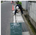
④二次蓋設置状況
