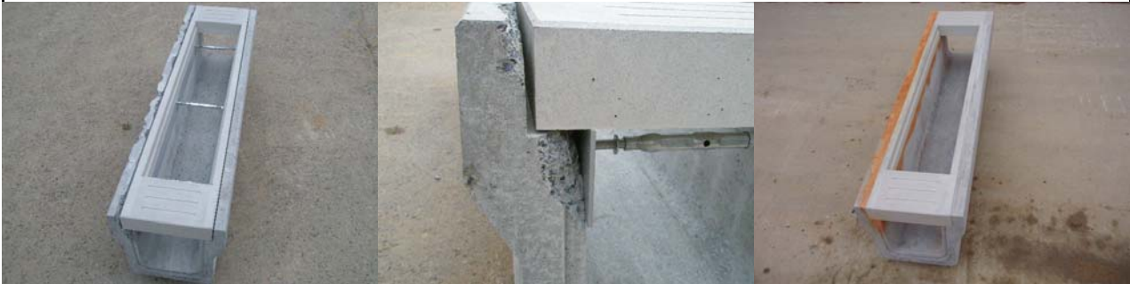
⑦バランスよく一次蓋を載せる ⑧一次蓋を仮置情況の拡大写真 ⑨軟らかめの無収縮モルタルを充填
