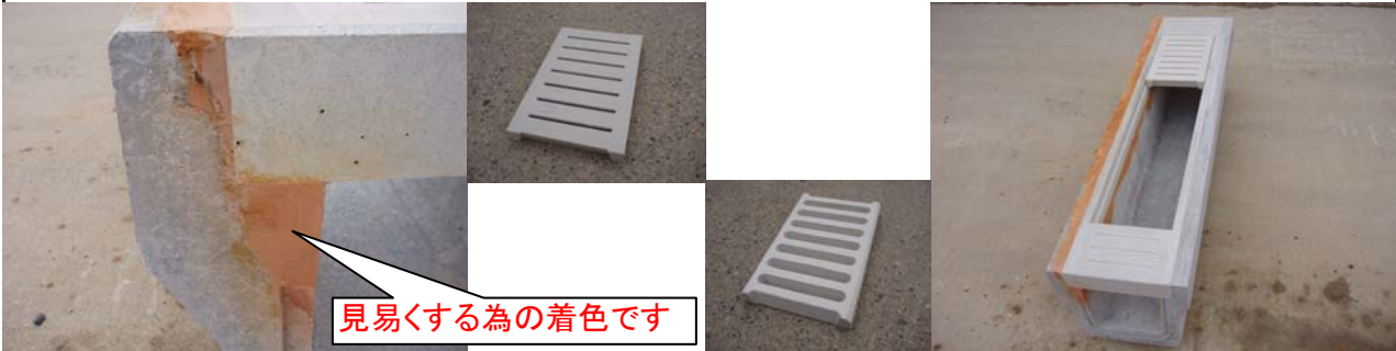
⑩斑無く充填し接着固定された状況 ⑪二次蓋の表面と裏面 ⑫二次蓋を順次設置し完成する
