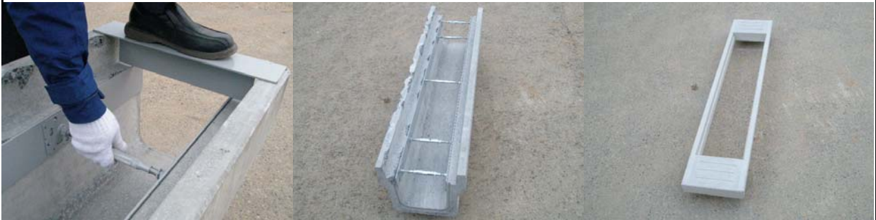
④定規に合わせて固定する ⑤固定完了(必要に応じて数箇所) ⑥ECONビ一次蓋
